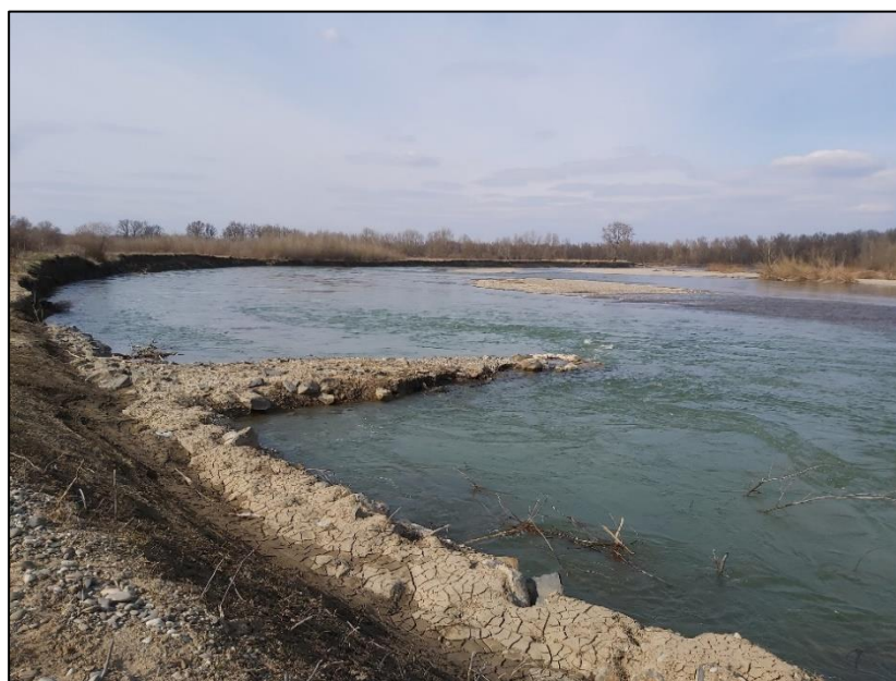
8. ábra: Parterősítés sarkantyúval az első vizsgálati kanyarulatunknál (Saját felvétel)
