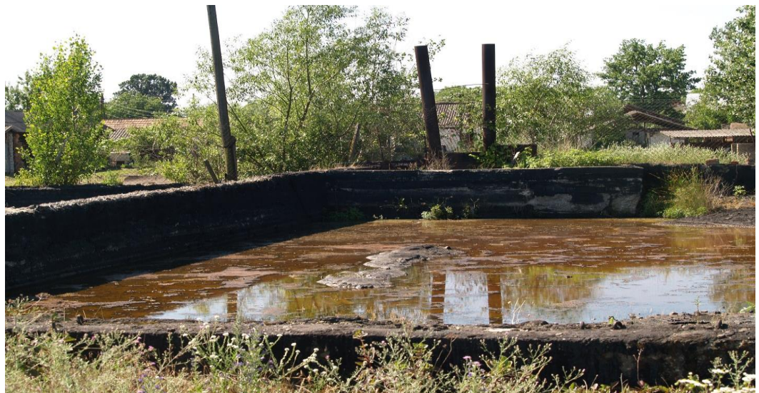
13. ábra. A tiszaujlaki üzemén kívüli bitumen előállító telephely betonozott medencéje.
